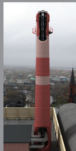
Многоствольная промышленная дымовая труба с трубами FURANFLEX
