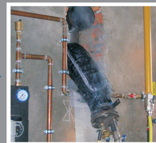
снизу от парогенератора в рукав подается пар; материал раздувается, по сечению дымохода
