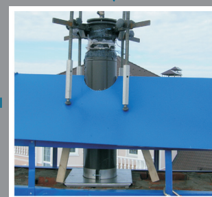
после термообработки (1-5ч) труба FuranFlex затвердевает
