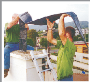
полимерный вкладыш FuranFlex вводится в газоход
