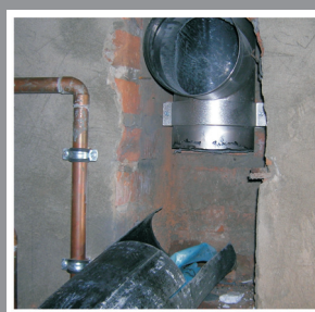
по окончании монтажа выступающие концы FuranFlex обрезают
