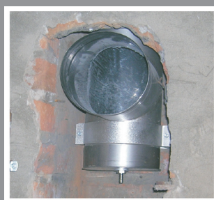
на нижнюю часть дымохода закрепляется заглушка отвода конденсата
