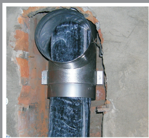
устанавливается тройник из нержавеющей стали, соединяющий котельное оборудование с дымовой трубой в газоход
